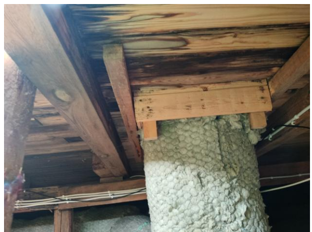
Kattoluukussa kosteusjälkiä.
