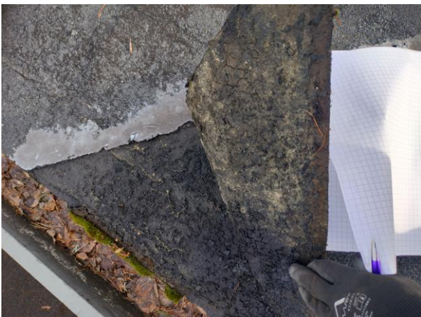
Jiirikermi on irti alustastaan. Se nousi helposti ylös.
