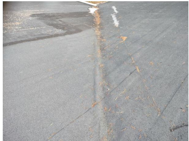
Jiirin kermi viety "vastakarvaan". Tämä lisää vuotoriskiä. Kermi osin poimulla.
