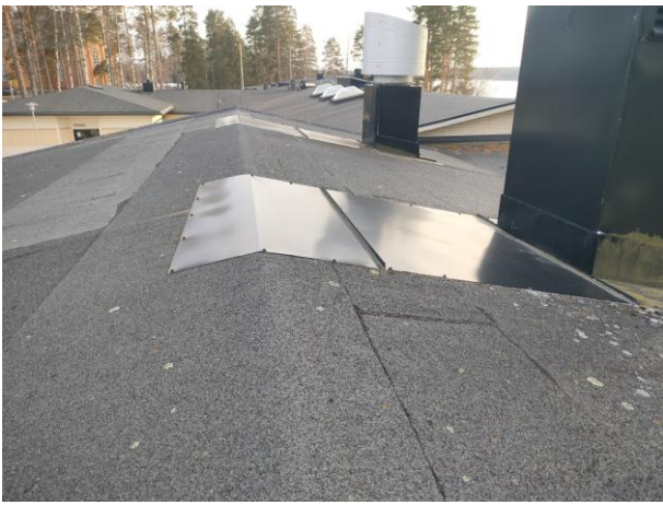
Iv-koneen jälkiasennus. Pelti kiinnitetty kateruuvilla kermin läpi.
