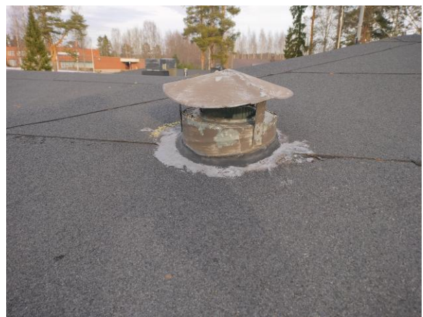
Katolla on yksi hyvin matala tuuletusputki.
