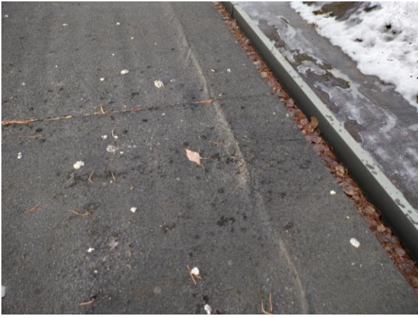
Tippapellin kohdalla kermi rutussa. Todennäköisesti tippapellin naulaus tehty harvaan ja se pääsee elämään liikkaa lämpötilan vaikutuksesta.
