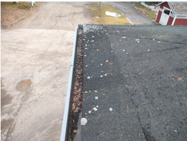
Kouruissa oli monin paikoin roskia. Katteen pinnassa on paikoin jäkälää ja sammalta.
