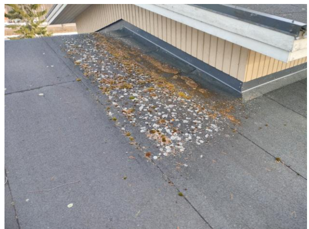
Kermikattoa tulee puhdistaa säännöllisesti.
