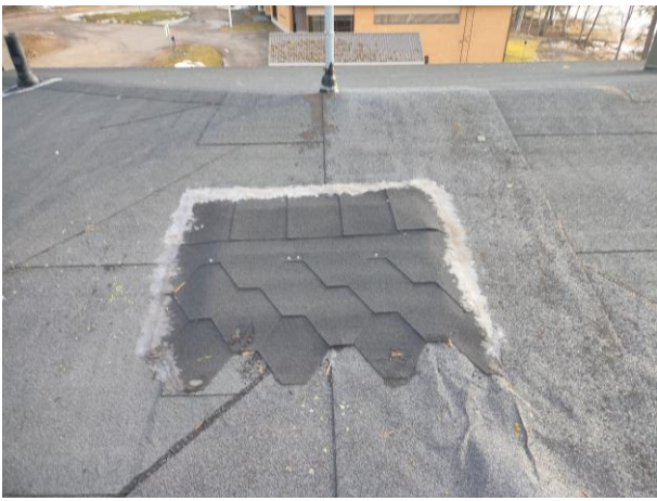
Katolla on tehty paikkaus palahuovalla. Palahuopa ei ole oikea tapa paikata kermikattoa.
