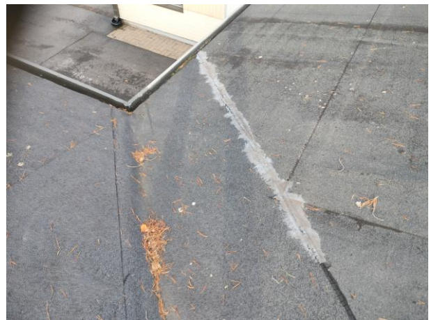
Saumaa on osin tiivistetty massalla.
