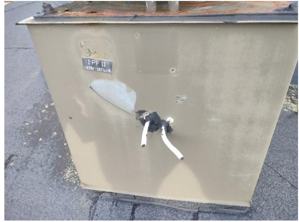
Pellissä on ruuvireikiä ja massa on rikki.
