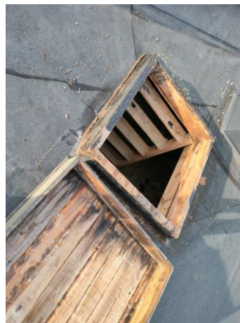
Kattoluukussa kosteusjälkiä.
