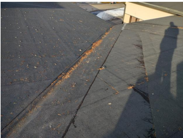
Jiirin pohjakerman sauma on tuotu lapekermin päälle. Kermi on hieman vastakarvaan.
