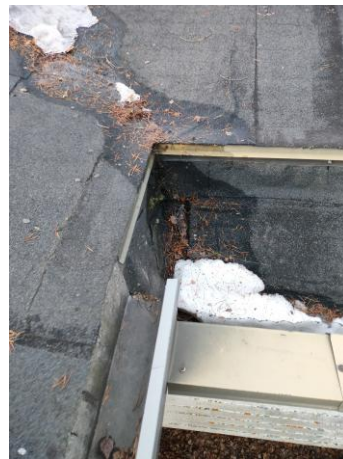
Jiirin kermi viety "vastakarvaan". Tämä lisää vuotoriskiä. Kermi osin poimulla.
