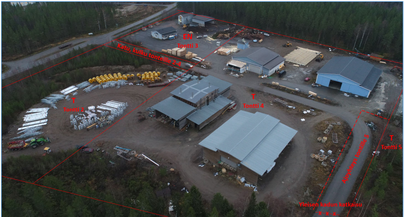
Ilmakuva Suunnittelualueen eteläosasta. Kuvaan havainnollistettu likimääräiset kaavarajat. Kivijärven rakennuspalvelu Oy omistaa tontit 2, 4 ja 5.
